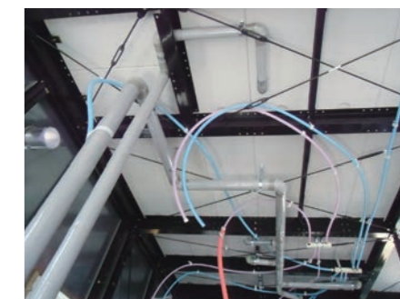
●鉄骨/トイレ・洗面1系統
