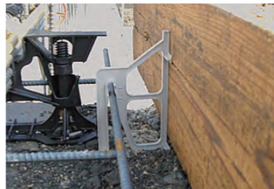
▲木製型枠施工写真
