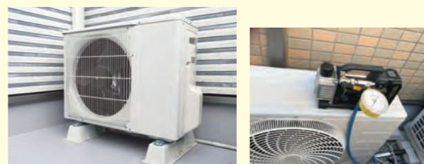
室外機とポンプ ※この画像はイメージです
