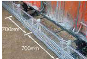
▲ラス製型枠施工写真
