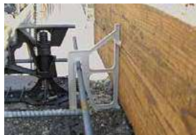
▲木製型枠施工写真
