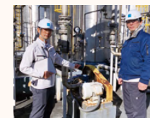
EHS点検の様子(2025年1月)
