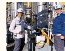
EHS点検の様子(2025年1月)
