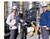
EHS点検の様子(2025年1月)
